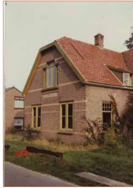
Koningsweg 5 voor de sloop 1985
