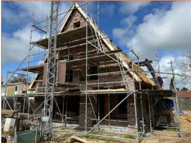
Voorweg 1, achtergevel in aanbouw
