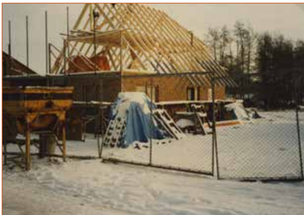
bouw nieuwe woning
